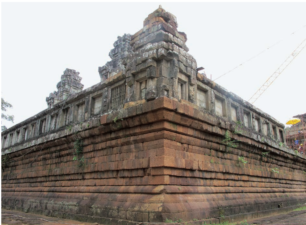
二层台西南角及角楼维修后
