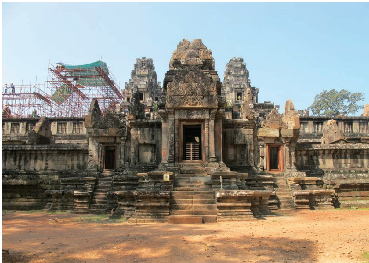
东外门维修后
