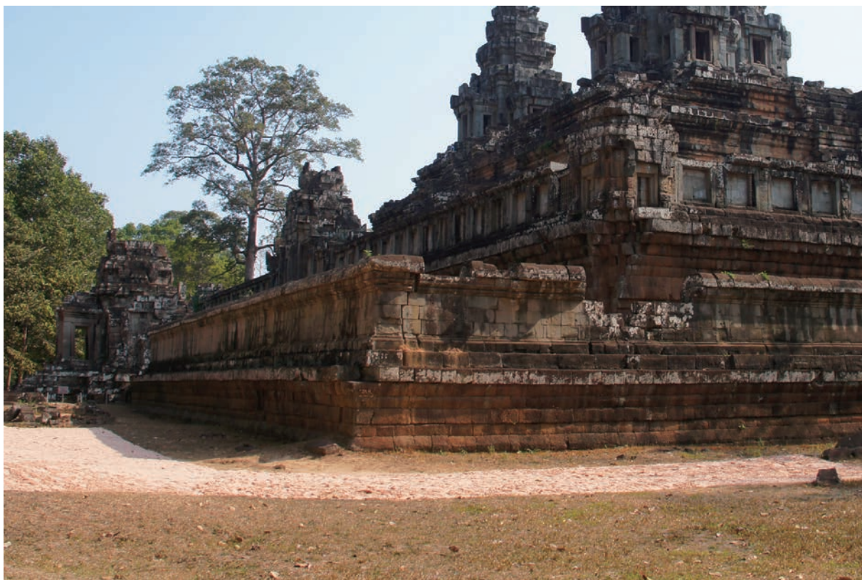
一层台西南角维修前
