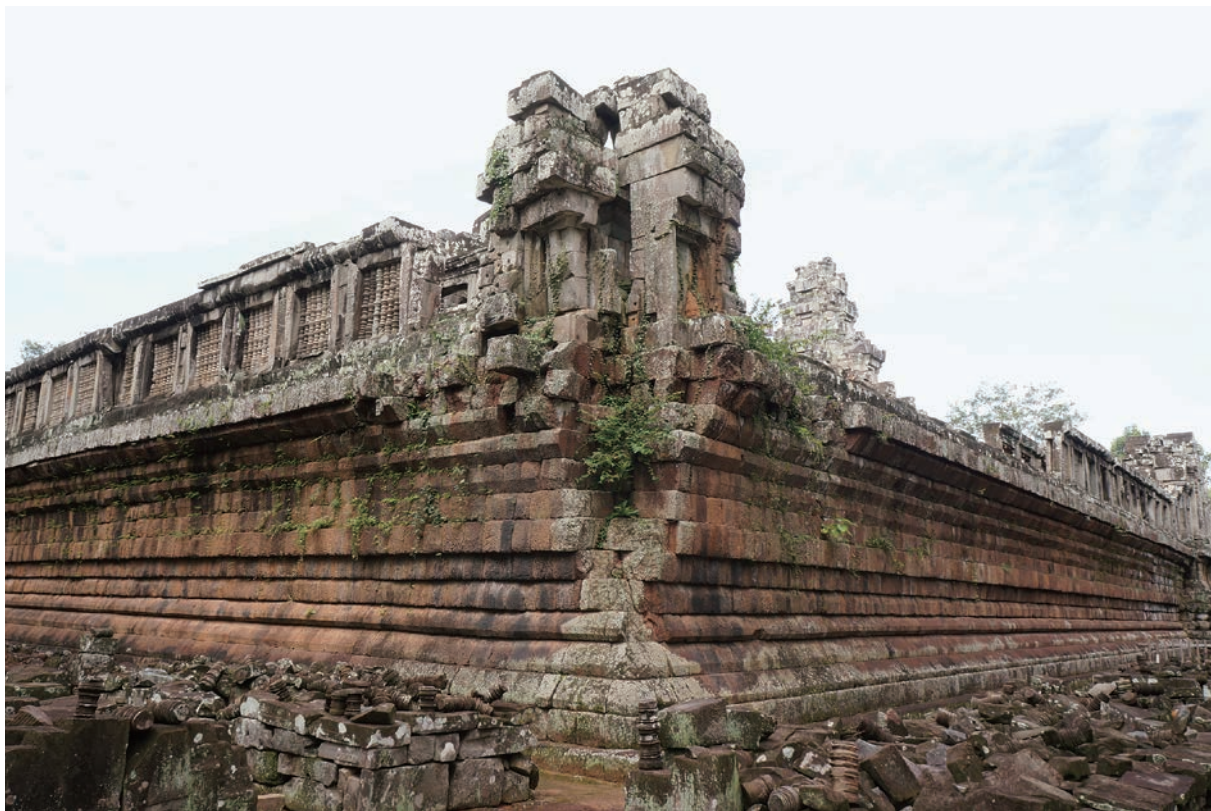
二层台东北角及角楼维修前
