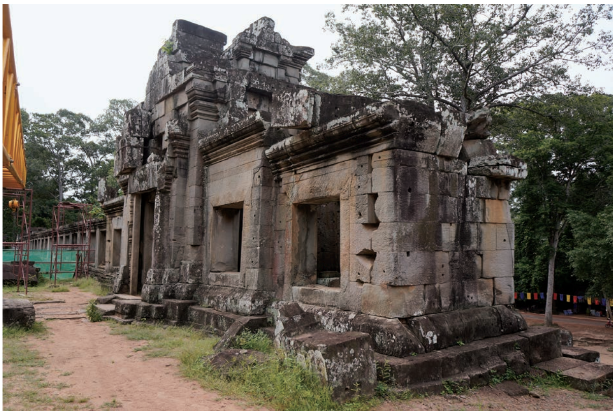
南内门维修前
