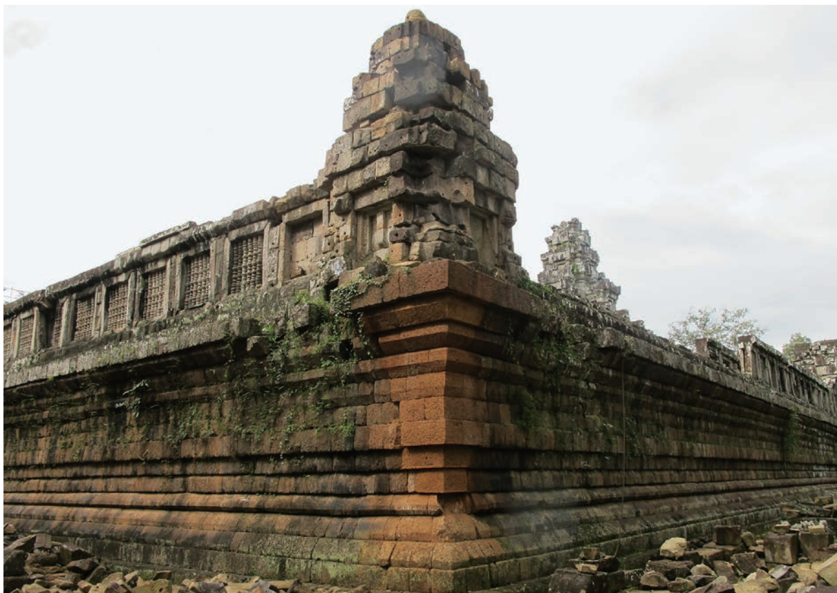
二层台东北角及角楼维修后
