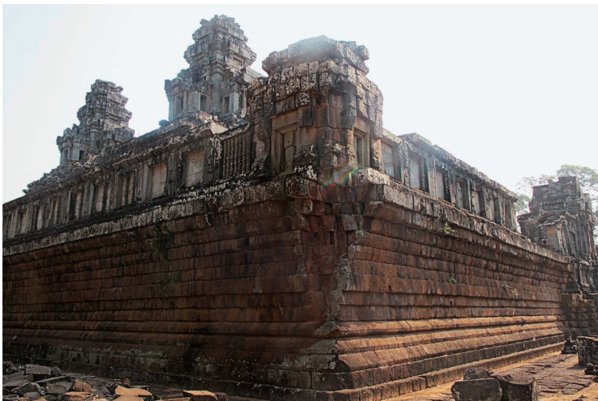
二层台西南角及角楼维修前
