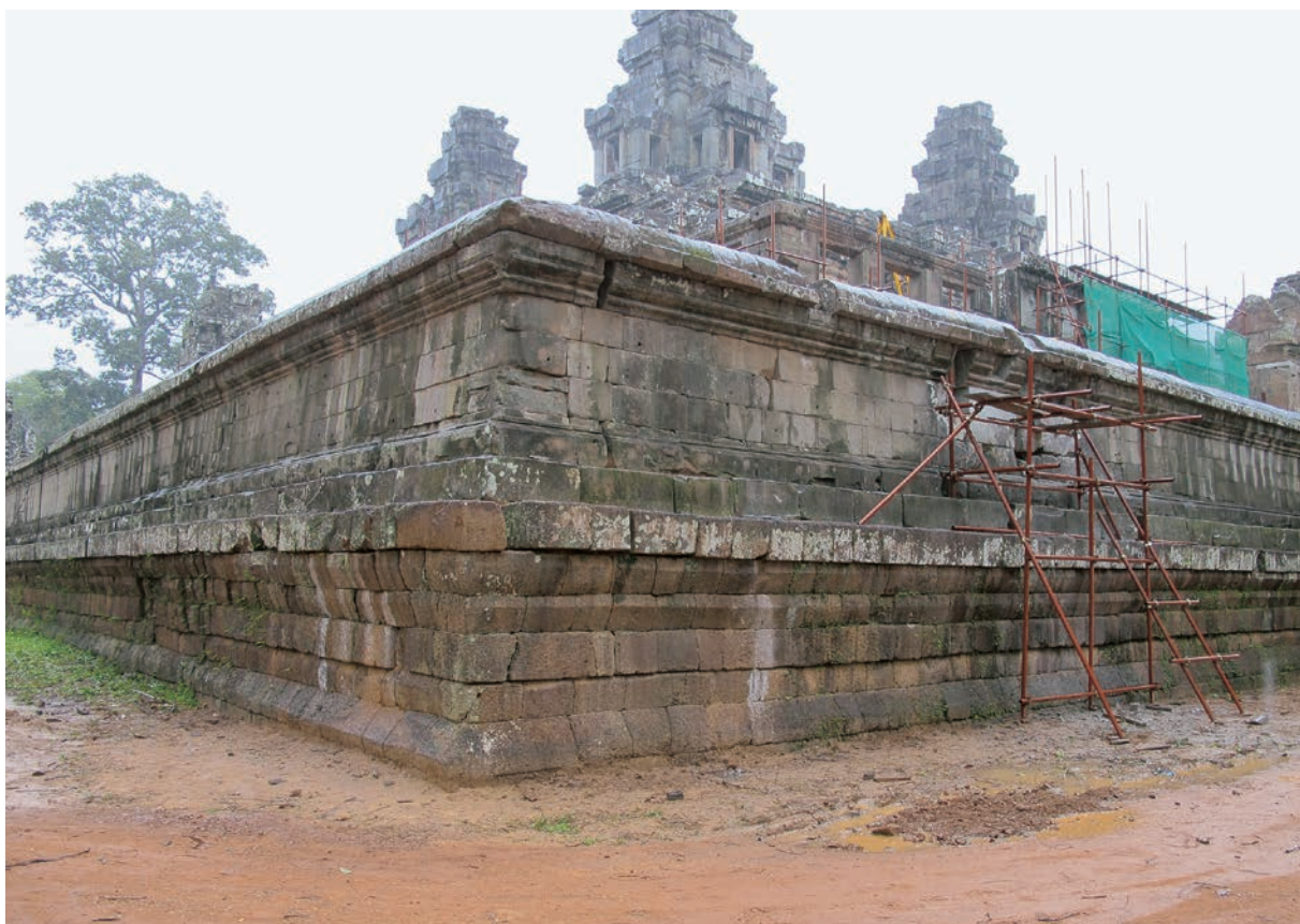
一层台西南角维修后
