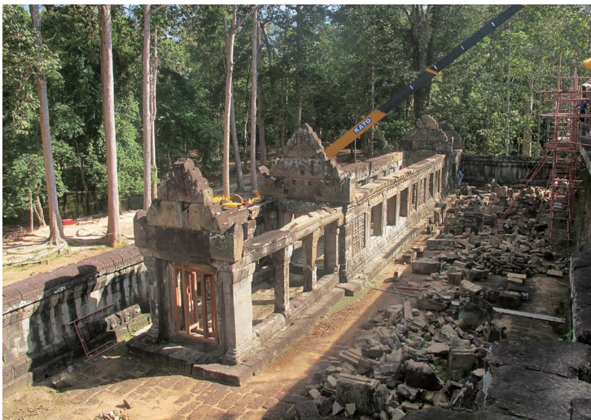
南外长厅维修后
