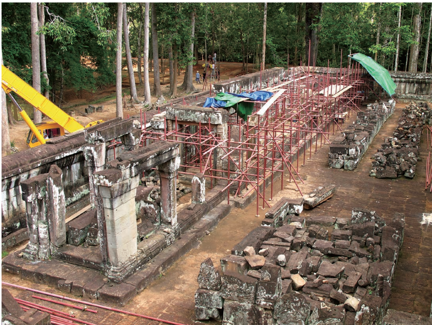
南外长厅维修现场图
