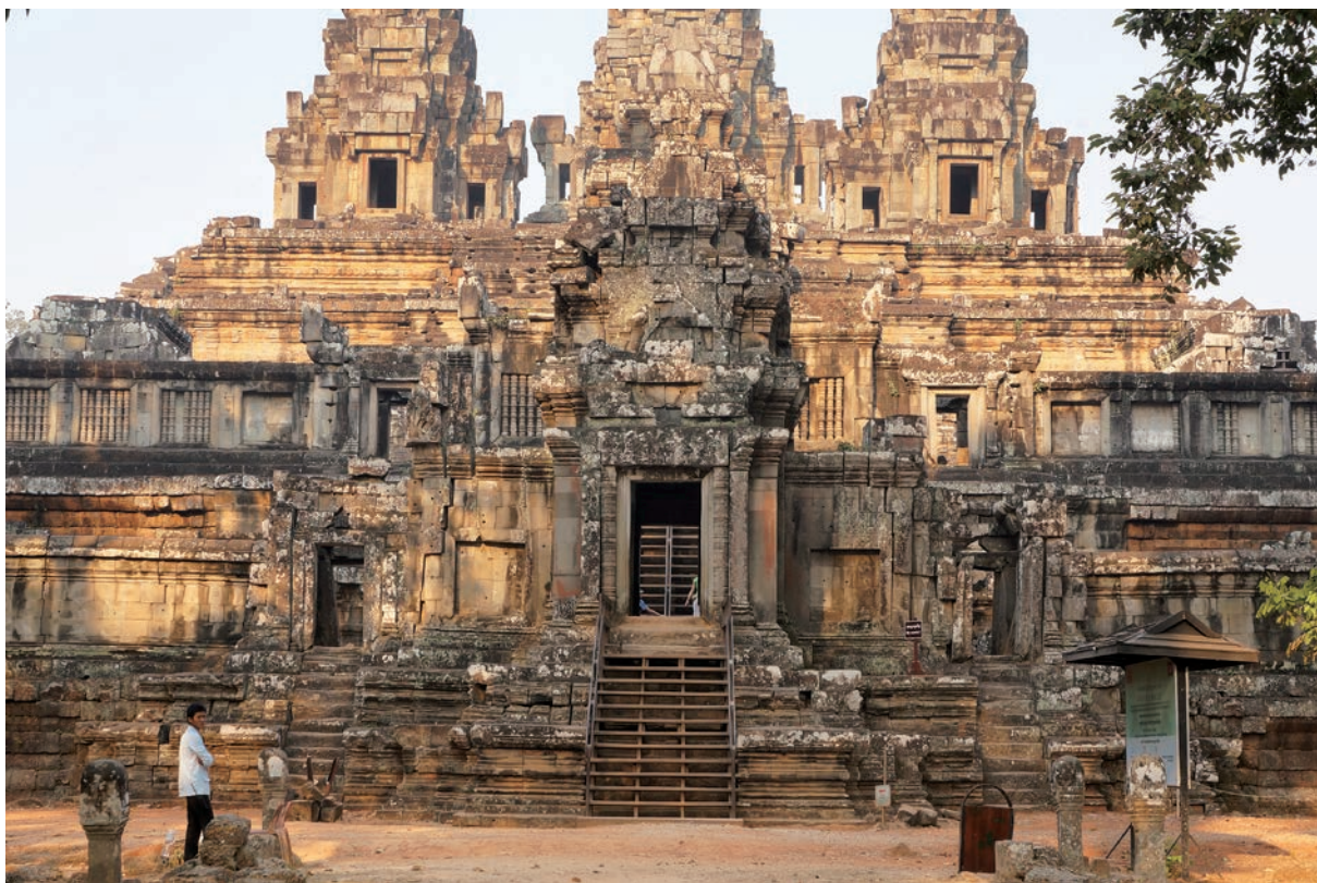
东外门维修前
