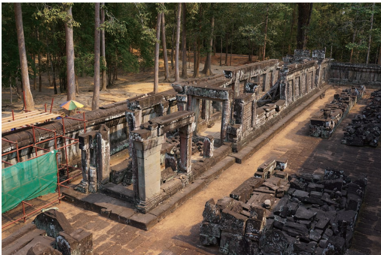
南外长厅维修前
