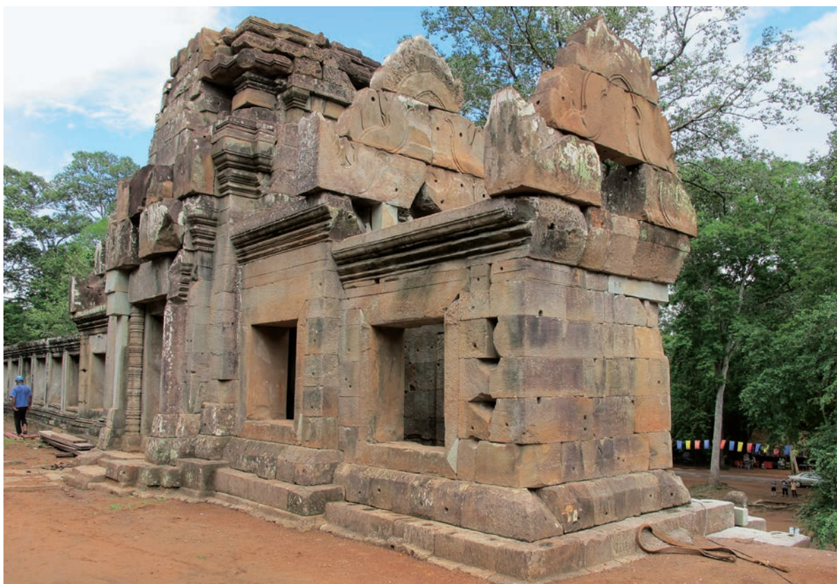
南内门维修后
